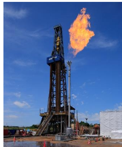
今回の検証範囲である南長岡ガス田のガスフローテストの様子(出展:INPEX 社)
